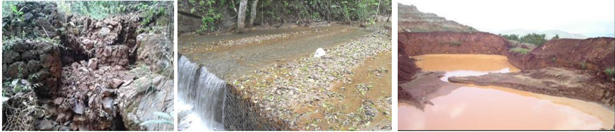
**Figuras 8a., 8b y 8c. Fotografías de las condiciones de deterioro y colmatación de las estructuras de retención de sólidos, CVM-SA, División Níquel, Tiara, estado Aragua.**
