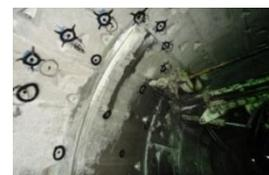
c.- Instalación vigas de refuerzo o estructura de apuntalamiento, en las aberturas del *CVD* y *CVI*, como refuerzo estructural, para mantener la transferencia de esfuerzos en los anillos, que fueron intervenidos parcialmente. Rotura cuidadosa de los anillos en el *CVD* con equipos perforador tipo *Core Drill*. Ingreso de los equipos de excavación.
