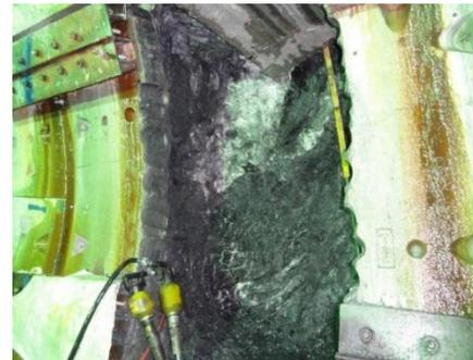
d.-Instalación de drenajes, excavación y colocación de costillas, proyectado de concreto. Impermeabilización tipo submarino, figura 11, colocación de armadura definitiva, figura 12, del revestimiento final, encofrado vaciado, figura 13. Losa de base vaciado en sitio, colocación de puerta figura 13, en el centro del pasillo y entrega al Cliente bajo el protocolo de la inspección utilizando como base las [12] “Especificaciones para el proyecto y construcción de los túneles”.
