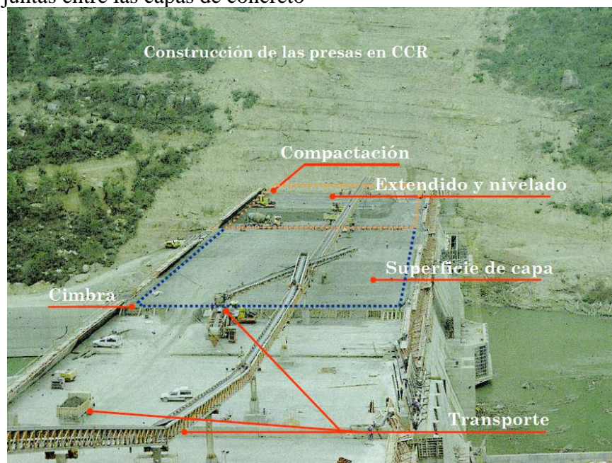
Figura 2. Esquema constructivo presas en CCR [2]
