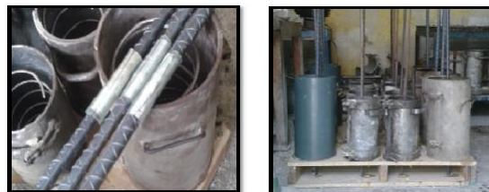
Figura 2. Colocación de manguera y refuerzo helicoidal
