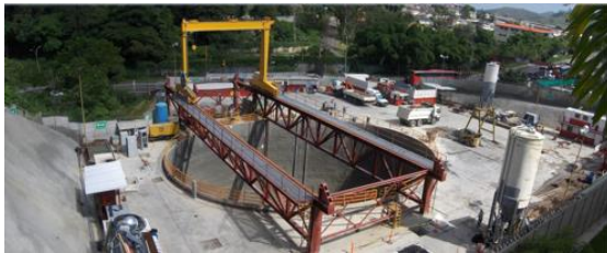
Figura 1. Pozo elíptico Macarena en la Línea II Metro Los Teques. Venezuela [1].
